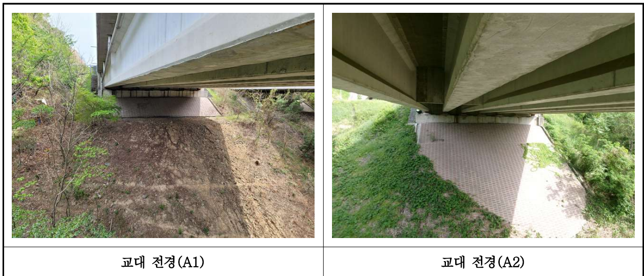
【사진 14.3.8】 교대 전경
