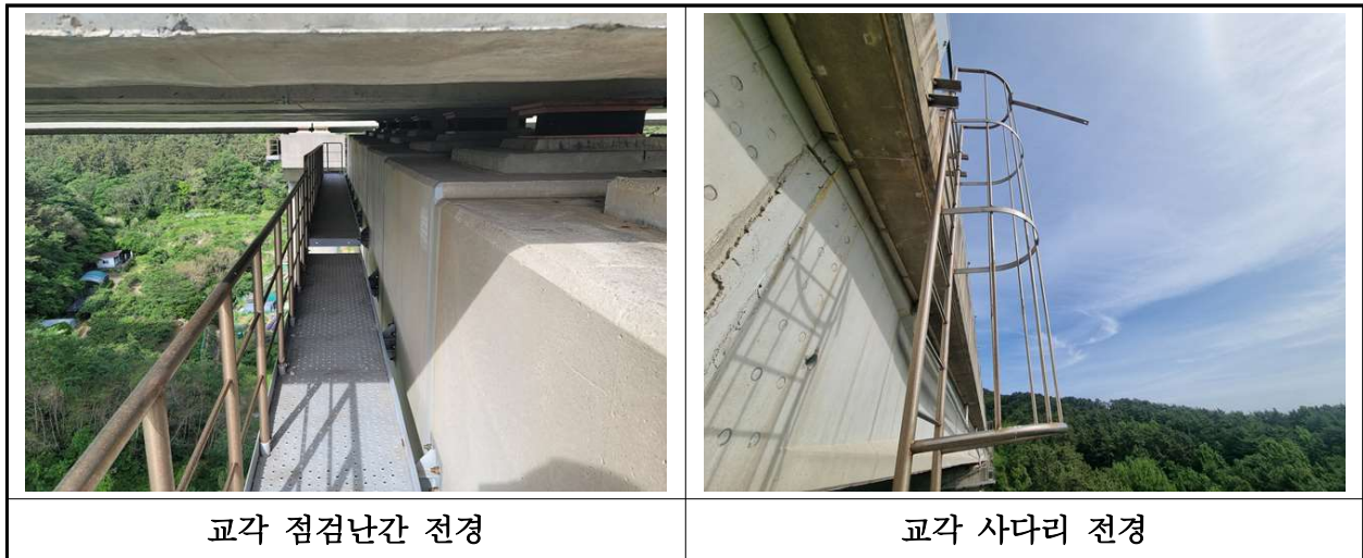
【사진 14.3.26】 교량 점검시설 전경
