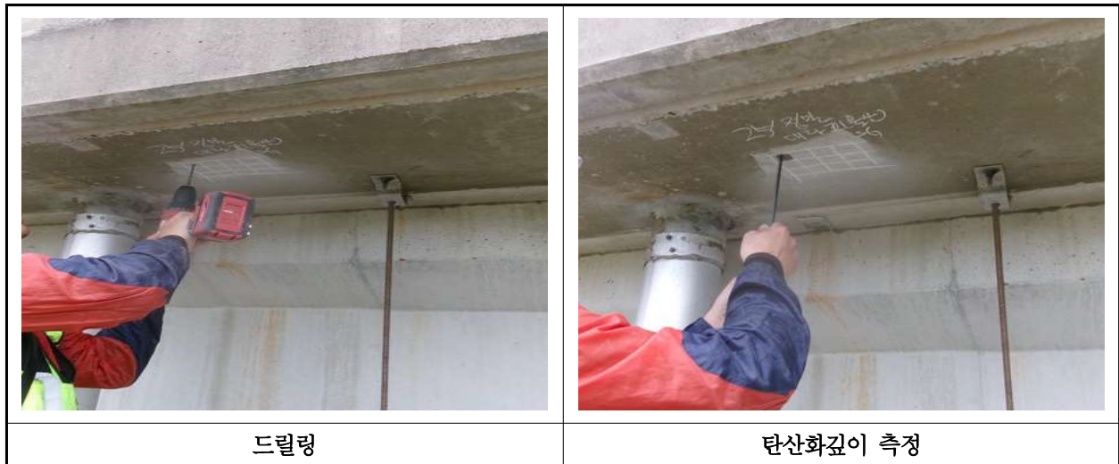
【사진 14.4.3】 탄산화 깊이 측정 현장사진
