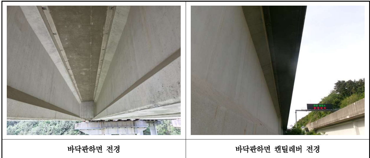
【사진 14.3.2】 바닥판하면 전경
