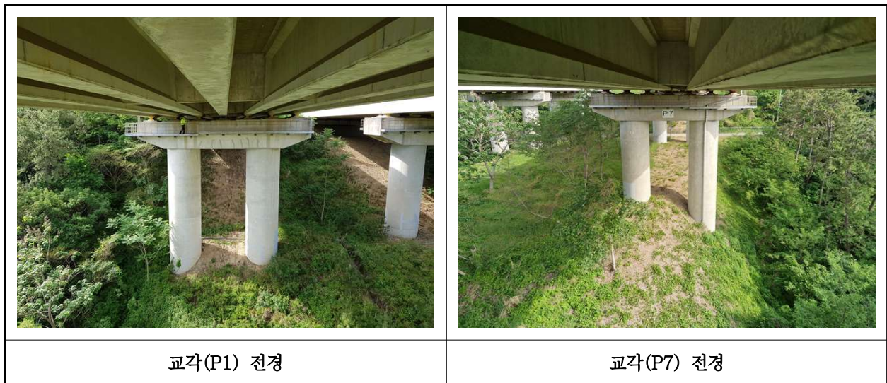
【사진 14.3.10】 교각 전경
